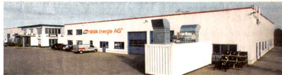
Platz für Lager und Produktion: Das Firmengebäude von Seva Energie in Emstek.
