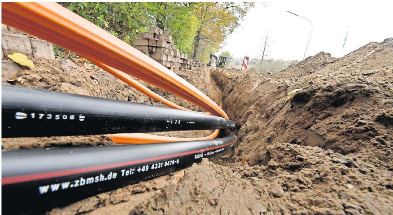
Für private Internet-Nutzer soll das Glasfaser nur bis zum Verteilerpunkt verlegt werden – vorerst.
